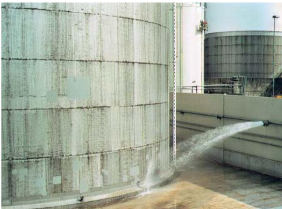
Abb. 7: Beschäumung des Bassins eines Stehtanklagers.
