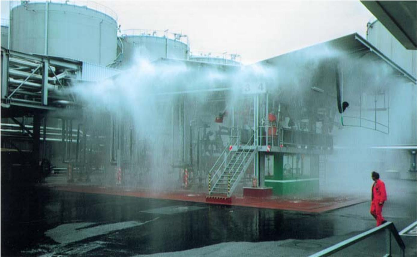
Abb. 4: Lösch- und Kühlanlage einer Füllstelle für Tanklastwagen.
