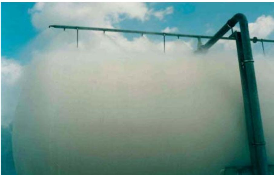
Abb. 1: Kühlung eines Flüssiggastanks.
